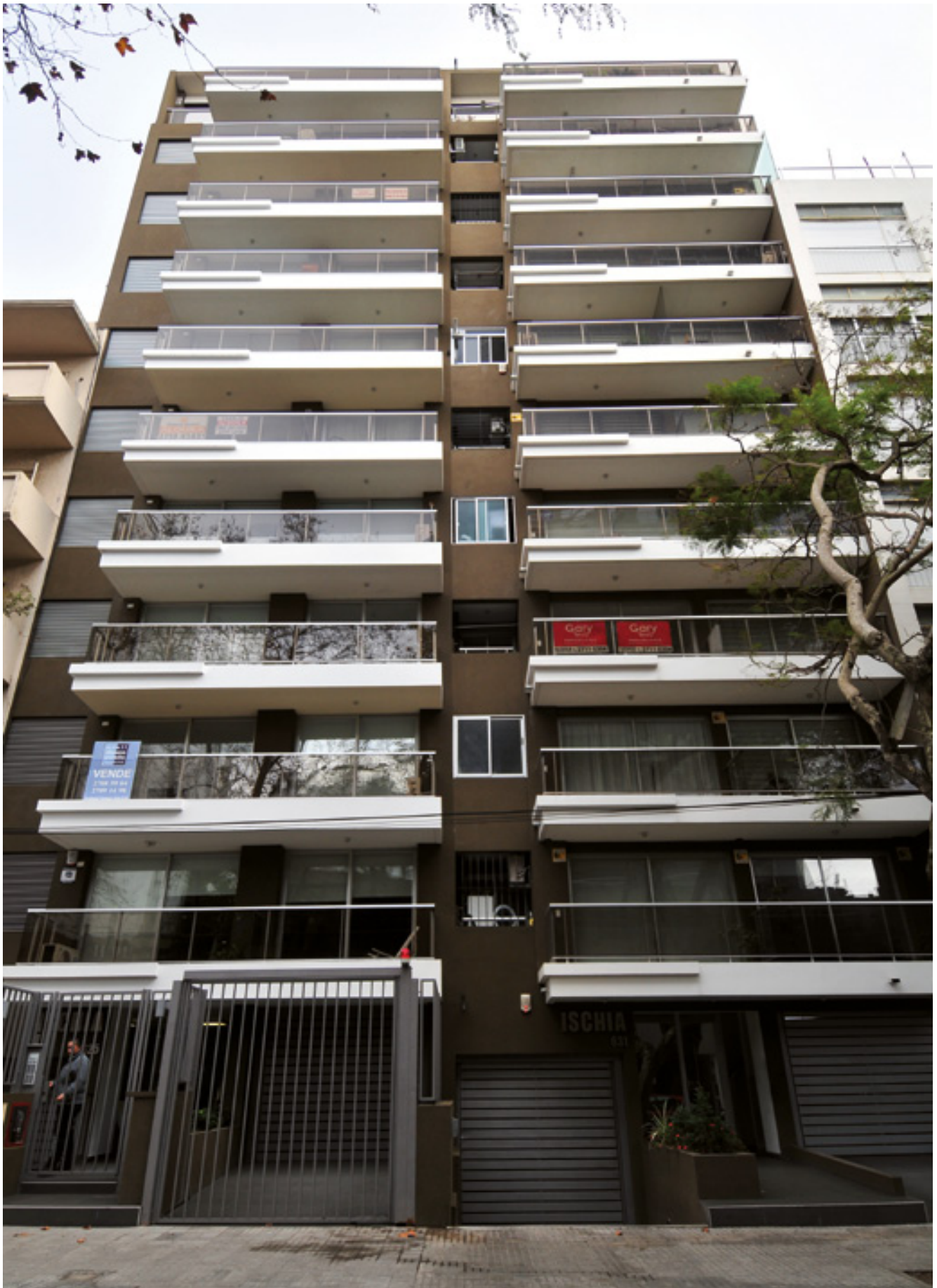
Entre los dos edificios se conforma un único plano de fachada, que adquiere un papel de telón de fondo para las terrazas, que mensulan sobre este.
